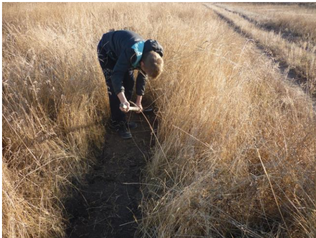
Фото 12,13. Выполнение минполосы шириной 0,5 м
